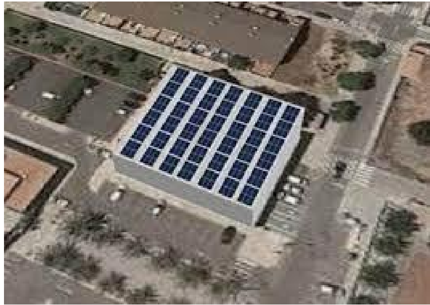
Fotografía de la instalación en la piscina municipal del Ayuntamiento de Canet d' en Berenguer
